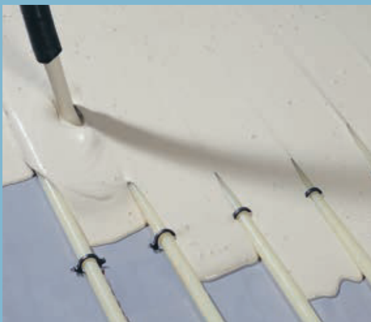
Knauf Calciumsulfat-Fließestrich verteilt sich geschmeidig um die Heizrohre der Fußbodenheizung Bauart A.
