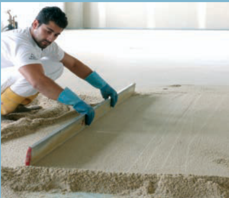
Der grob verteilte Knauf Stretto kann leicht mit der Abziehlatte abgezogen werden.
