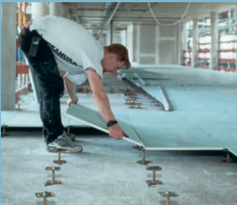
Das Knauf Hohlbodensystem Camillo besteht aus dem Schalungselement, der Knauf Schrenzlage und dem Knauf Fließestrich FE 80 Allegro ab 38 mm.
