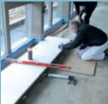
Montage eines GIFAfloor FHB
