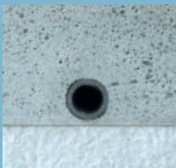
Knauf Fließestrich umhüllt optimal das Heizrohr und gibt die Wärme schnellstmöglich an die Oberfläche weiter.
